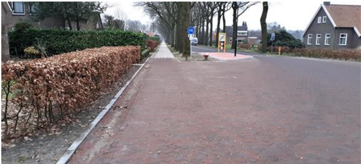
Foto 8: Begin c.q. einde verplicht fietspad ten noordoosten van de aansluiting Visserstraat
