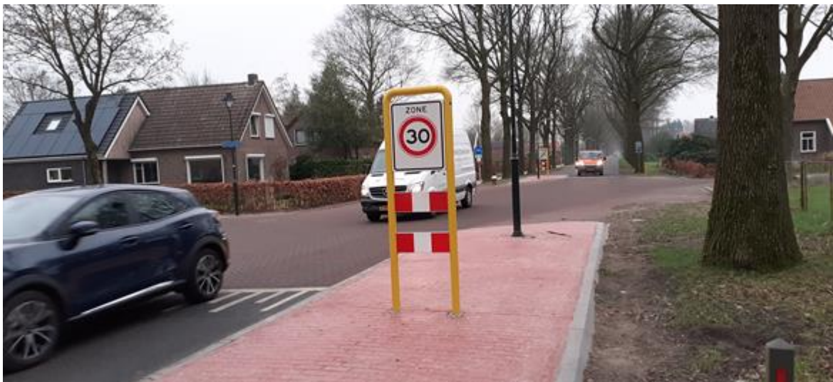
Foto 2: Tegemoetkomend verkeer vanuit de richting Valthe
